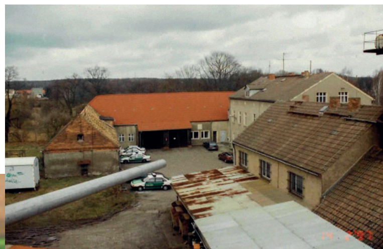
Das Reviergebäude vor der 2004 fertiggestellten Sanierung, das Gebäude im Vordergrund wurde dabei abgerissen.
