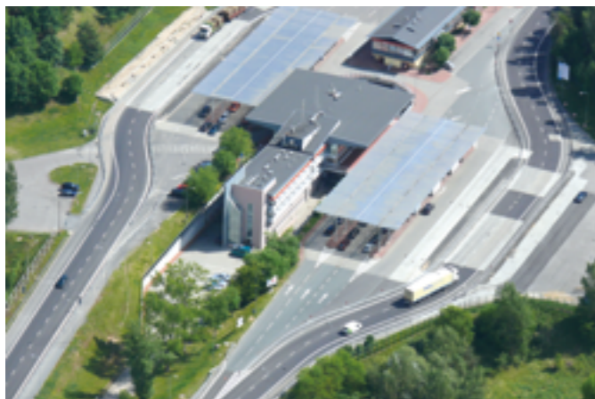
Luftaufnahme der alten Liegenschaft des GZ in Świecko
